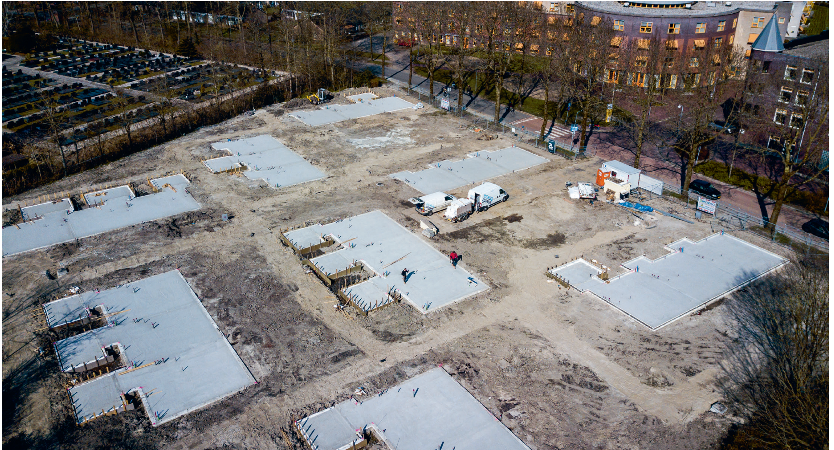
Versterkingsoperatie: Sloop-nieuwbouw Ten Boer
